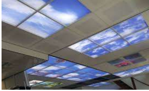
شكل (14) استخدام ألواح ضوء النهار بالأسقف للمساعدة في تحقيق جودة البيئة البصرية https://i0.wp.com/www.proskypanels.com/wp-content/uploads/2018/10/Sky-panel.jpg?w=600 (20-8-2019)
