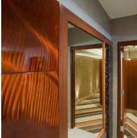
شكل (16) استخدام ألواح الألومنيوم المغلفة في التصميم الداخلي و التي تعمل كعازل صوتي
